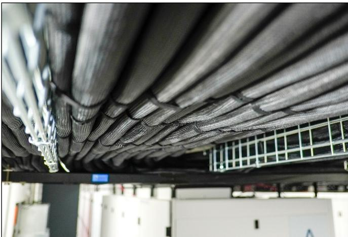
Incluso instaladas boca abajo para encajar en el espacio limitado, las Bandejas para Cables de CPI proporcionan el soporte adecuado para los cables.
