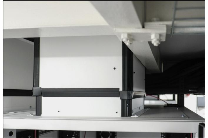
Los Ductos de Escape Vertical personalizados de CPI aíslan, redireccionan y reciclan el aire de escape caliente para mejorar las ineficiencias de enfriamiento.
