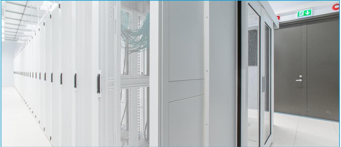
El kit BTS de CPI aísla eficazmente el aire caliente de escape y lo lleva de vuelta al acondicionador de aire, lo que aumenta la eficiencia de enfriamiento.
