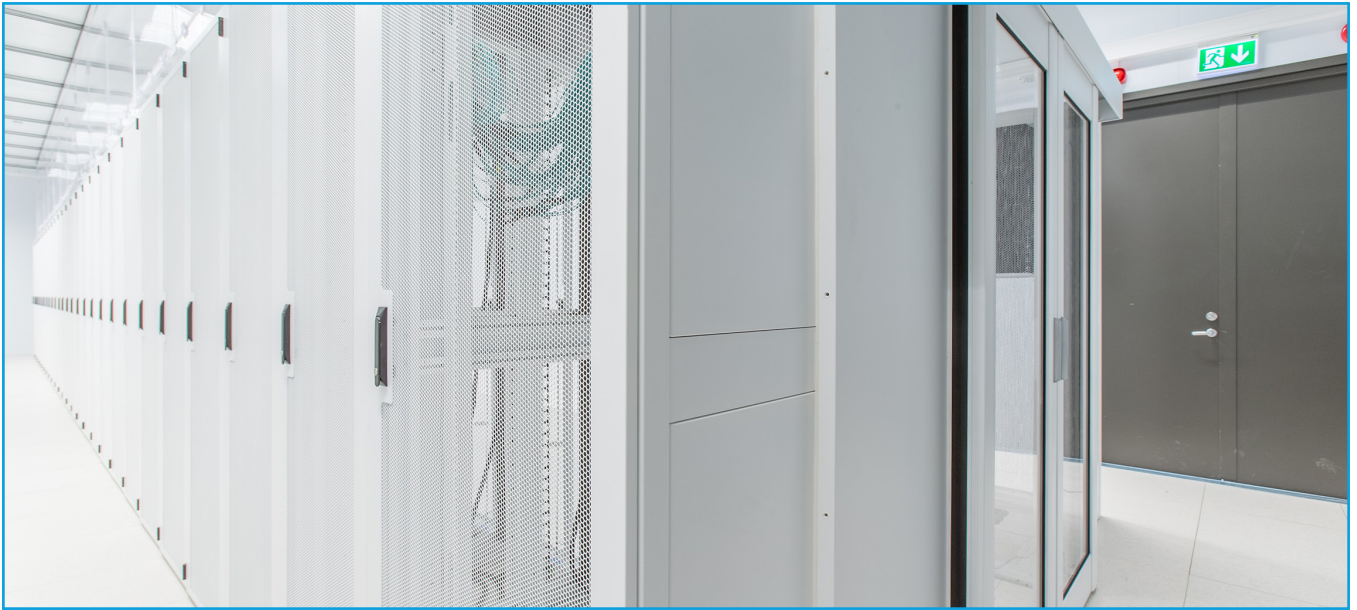
CPI 的 BTS 组件能有效隔离热排气，将其引导回空气处理器，从而提高了冷却效率。
