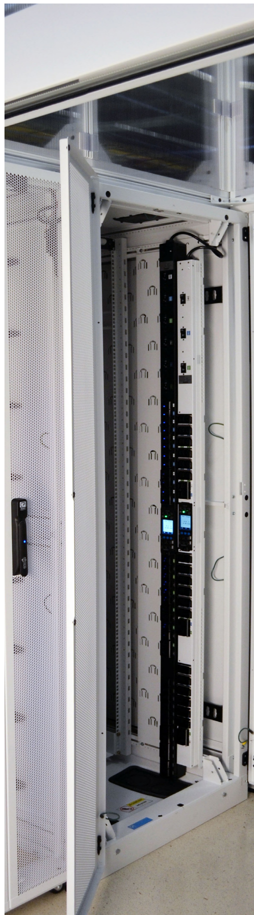
Figura 1: Las PDU en bastidor inteligentes se utilizan para distribuir la energía en gabinetes y bastidores de TIC. Modelos selectos incluyen la capacidad de encender, apagar o reiniciar cada tomacorriente.
