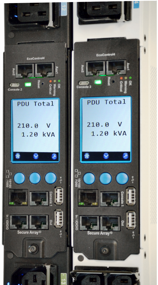
Figura 3: La supervisión de la energía remota captura datos que se pueden utilizar en el DCIM para establecer tendencias en el uso de la energía, estimar la capacidad restante, ajustar el equipo infrutilizado y asegurar la conmutación por error.
