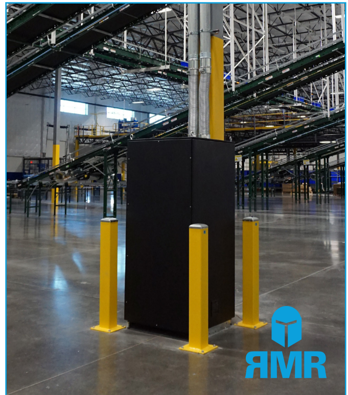
El recinto modular RMR® de CPI está diseñado para proteger equipos con tecnología de sellado de vanguardia y grados de protección de entrada certificados.
